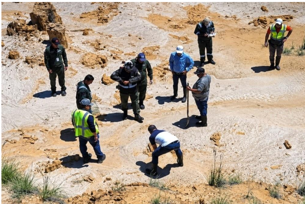
Tina de relave A, sin tina de contención y los sedimentos expuestos a erosión.
