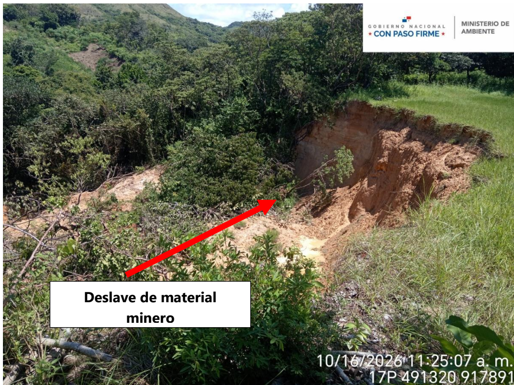
Tina de Relave B, actualmente sin muro de contención y los sedimentos llenos de pasto humidícola.
