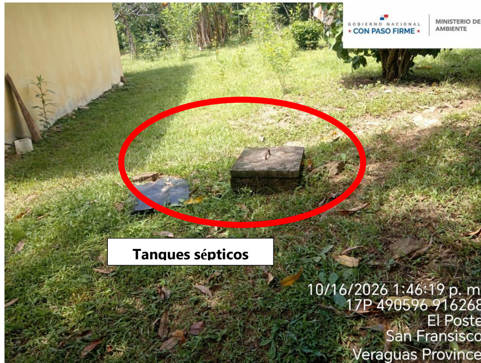
Tanques sépticos pertenecientes a 5 familias que viven cerca de la quebrada veneno.
